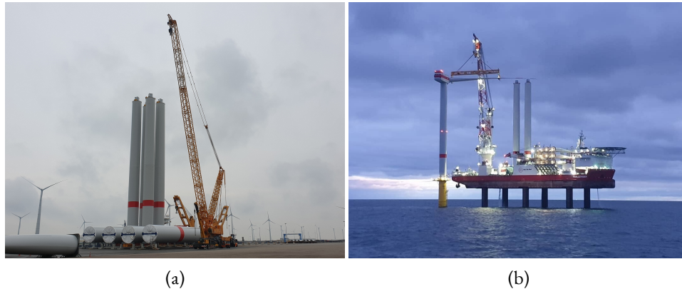
Abbildung 2.32: Prozessschritte der Installation einer Offshore-Windenergieanlage. (a) Zusammenbau und Aufrichten der Türme am Kai im Basishafen. (b) Einzelblattmontage auf hoher See (Foto mit freundlicher Genehmigung von M. Barbei, Senvion).
